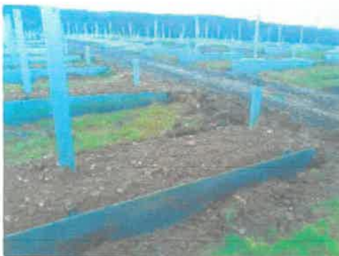
Figure 21 : Fondations externes (longrines) au sein de la centrale photovoltaïque de Saint-Quentin-la-Tour (09)
