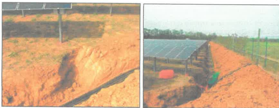
Figure 24 : Tranchée drainant le courant continu
