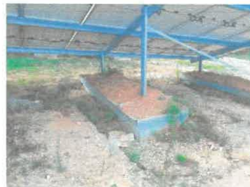
Figure 21 : Fondations externes (longrines) au sein de la centrale photovoltaïque de Saint-Quentin-la-Tour (09)
