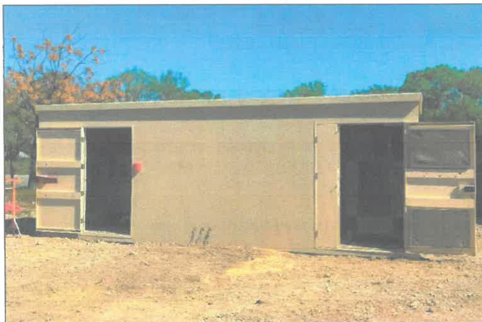
Figure 11 : Exemple de postes de livraison et de livraison (Source : VALECO)
