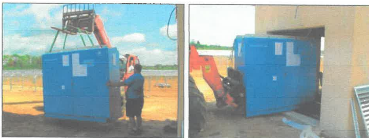
Figure 26 : Installation d'un onduleur
