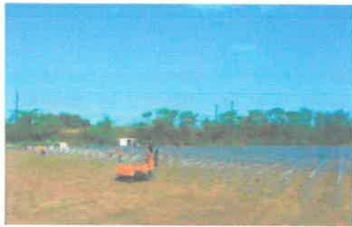
Battage des pieux
