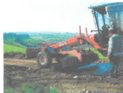
Pose du géotextile
