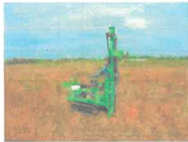
Sondage au pénétromètre
